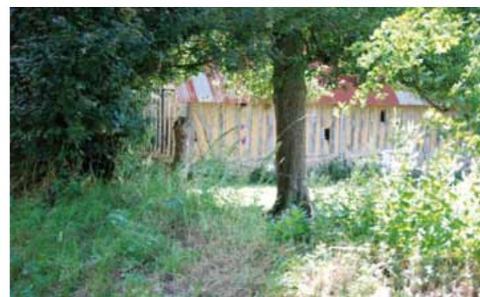
Talus planté et bâtiment ancien : des habitats variés correspondant aux besoins des chauves-souris.
